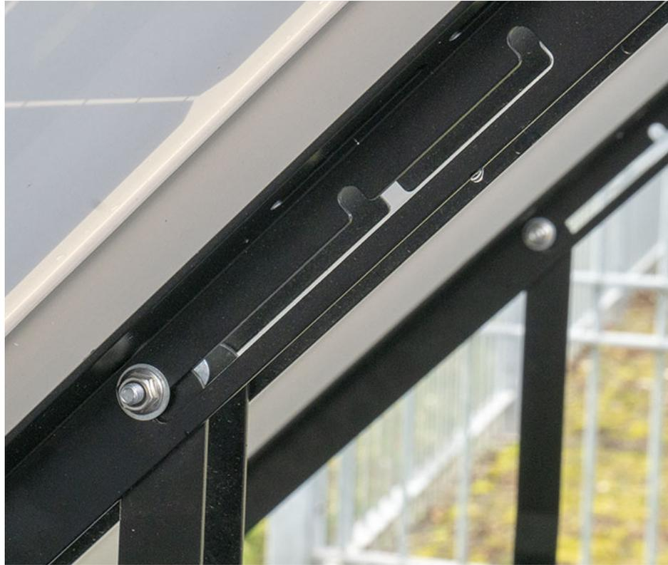
Abbildung 7: Rastverstellung der Solarpaneele
